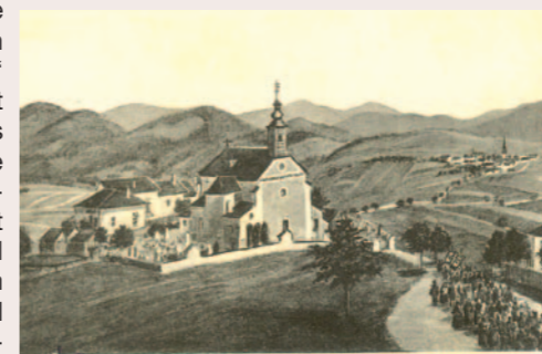
Wallfahrtsort ANNABERG bei Wiesmath Wallfahrer aus dem Burgenland auf dem Weg zur Annakirche in Wiesmath Foto: Karl Mühl, Wiesmath
