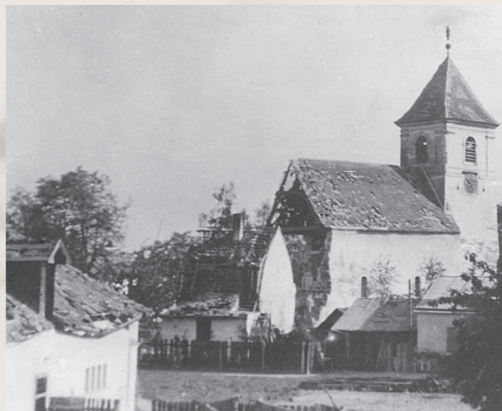
Schwer beschädigte Pfarrkirche, Foto: Gem. Katzelsdorf 1944
